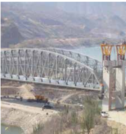
Infiernillo Bridge, Lázaro Cárdenas, México
