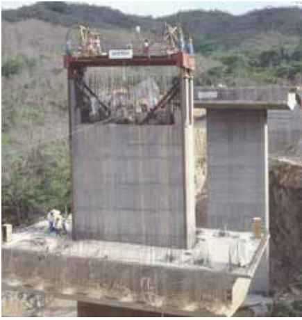
El Pozuelo Bridge México-Acapulco Highway
