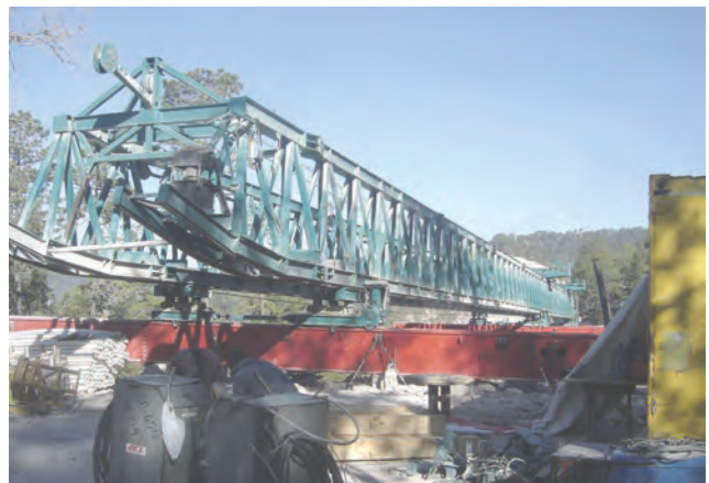
El Indio Bridge, Durango-Mazatlán Hwy
