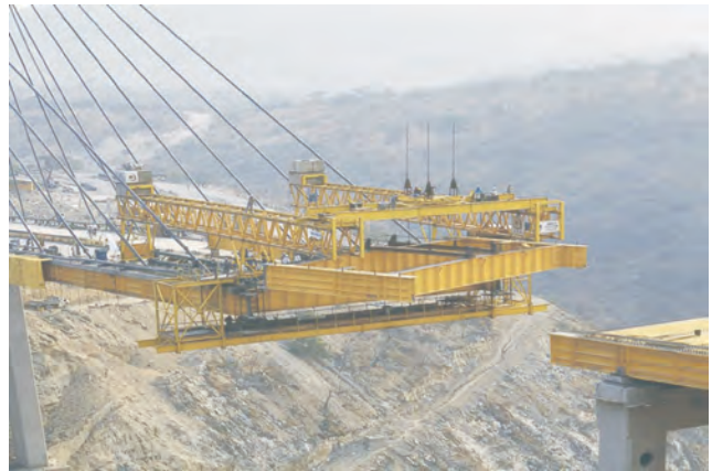
Barranca El Cañón” Bridge, México-Acapulco Highway
