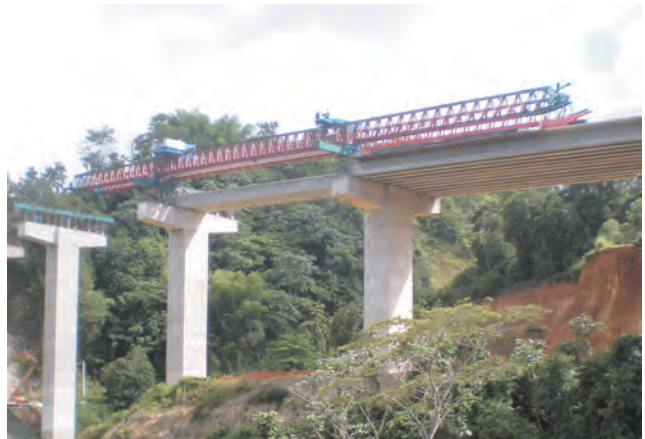
Utuado-Adjuntas Bridge, Puerto Rico
